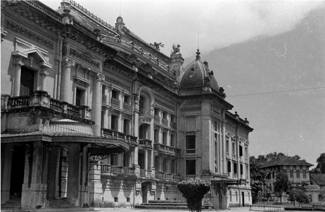
Các cổng hiên này không được tìm thấy trên các bản vẽ nguyên thủy của tòa nhà vào năm 1901. Chúng được thêm vào sau khi tòa nhà đã xây xong. Hình do thành viên Flickr "manhhai"
